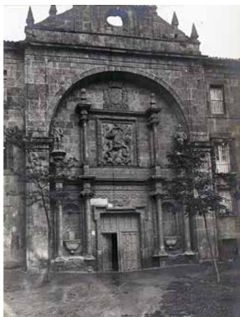
■ Desde la ventana de la parte inferior derecha de la portería la botica del monasterio expendía los medicamentos a los vecinos del pueblo. La ventana disponía de una reja.
